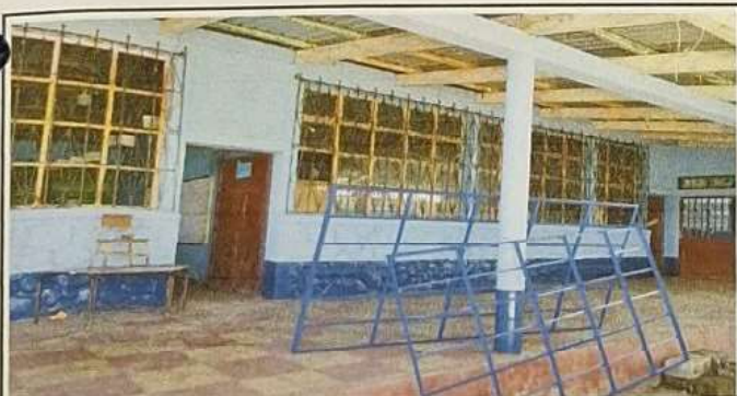
Foto 5: cambio de balcones
