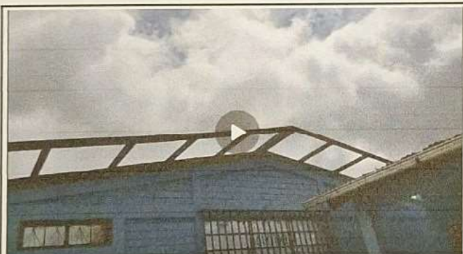
Foto 3: Cambio de techo de la escuela
