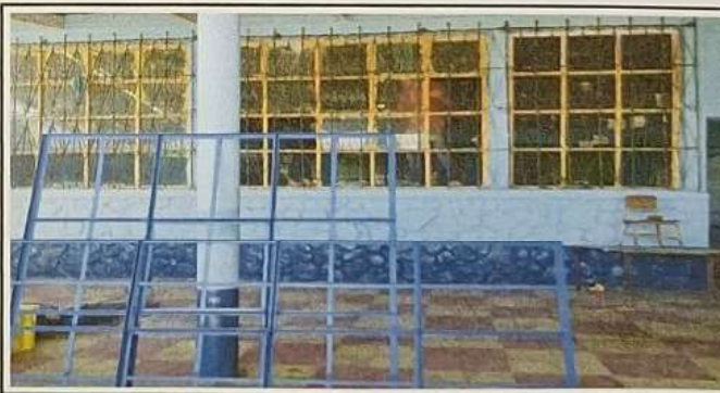
Foto 6: cambio de balcones
