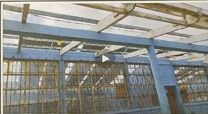
Foto 4: Cambio de techo de la escuela
